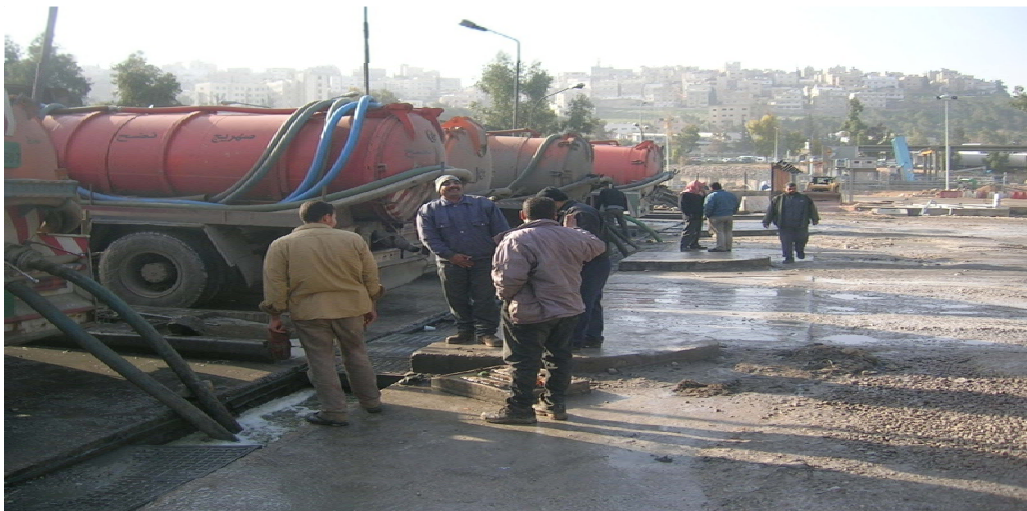
Figure 1 – Ein Ghazal Septage Receiving Station
